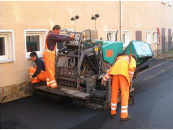
Wenige Tage vor dem Wintereinbruch konnte wir unseren Hof in Tauscha sanieren
