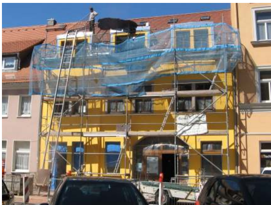
Dach- und Fassadenerneuerung in Bautzen
