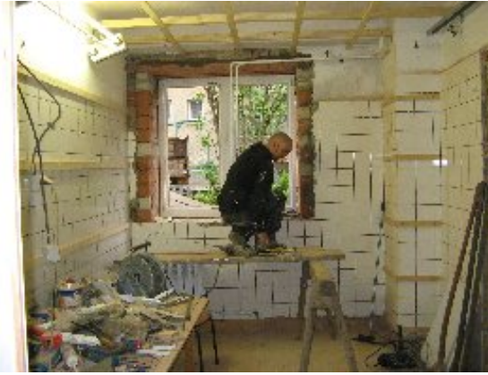
Fenstereinbau für den neuen Gesprächsraum in Tauscha
