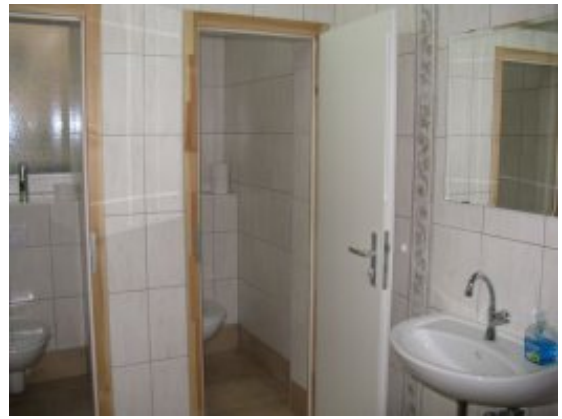
Fertiggestellte WC-Räume in Tauscha
