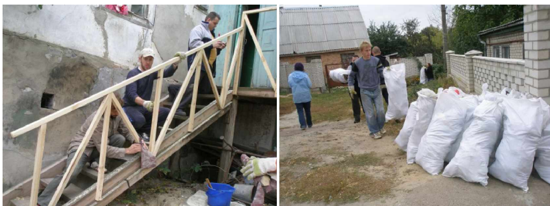
.....Geländer schleifen und streichen.....
