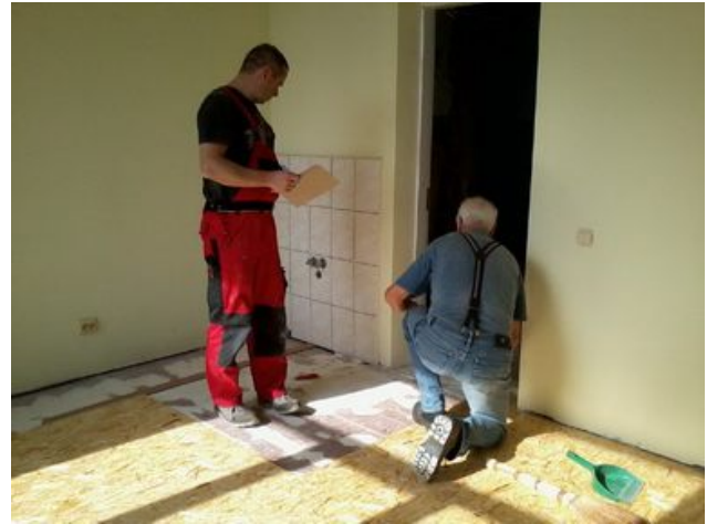
Fußboden- und Heizungserneuerung in Cherkassy
