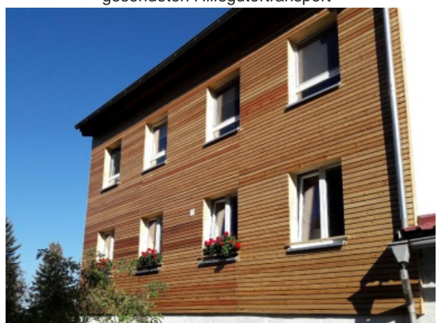
Fertiggestellte Hausfassade in Tauscha
